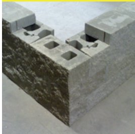
Girning av toppsten i hörn
