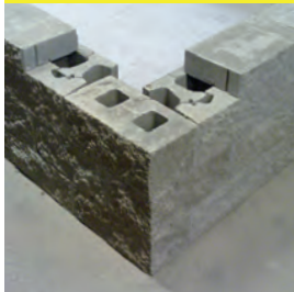
Girning av toppsten i hörn
