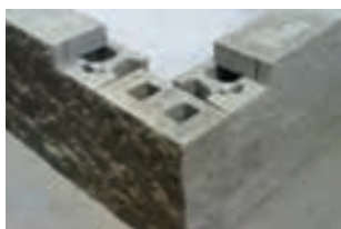
Girning av toppsten i hörn
