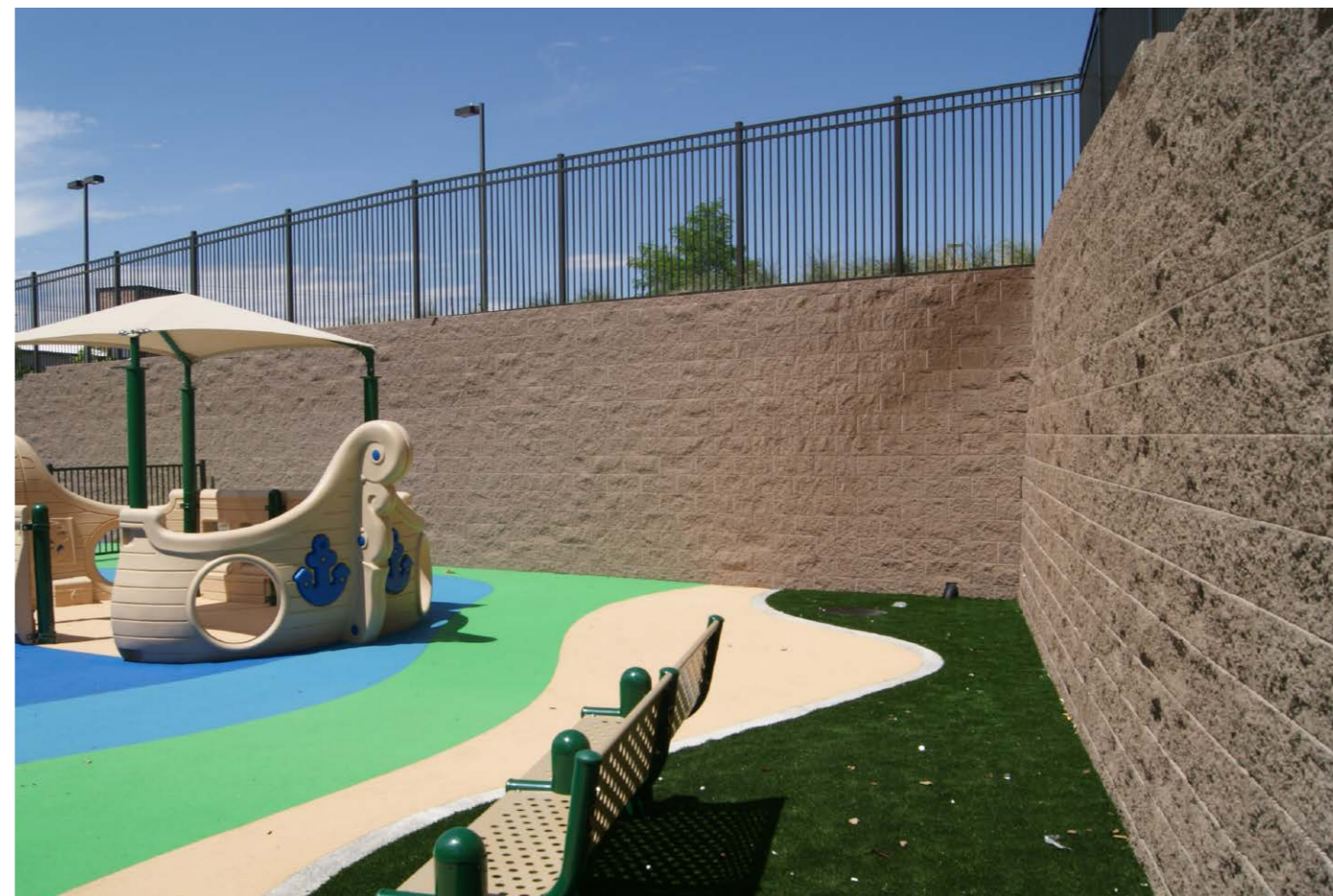
Muren monteras helt utan murbruk och specialverktyg. Den enkla tekniken ihop med estetiska uttrycket öppnar upp för oändligt med möjligheter.
