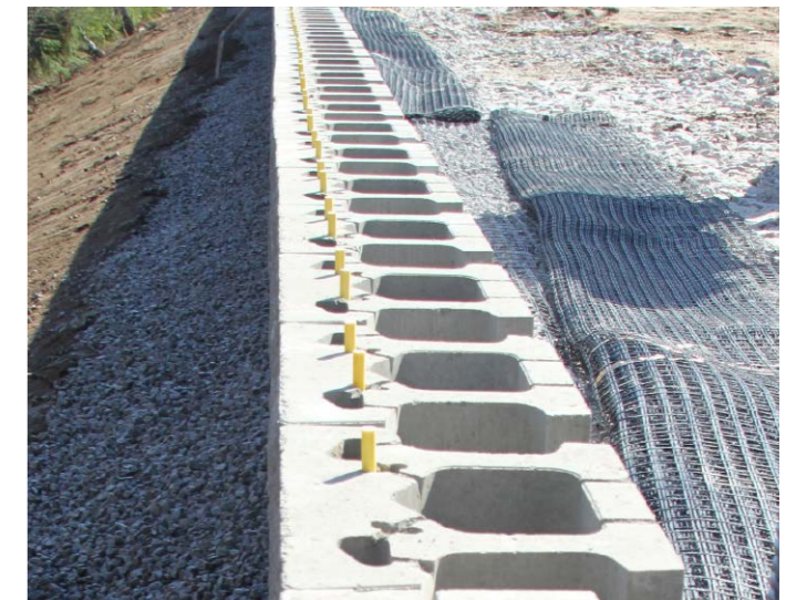
Glasfiberstavarna är starka, lätta och rostar inte.
